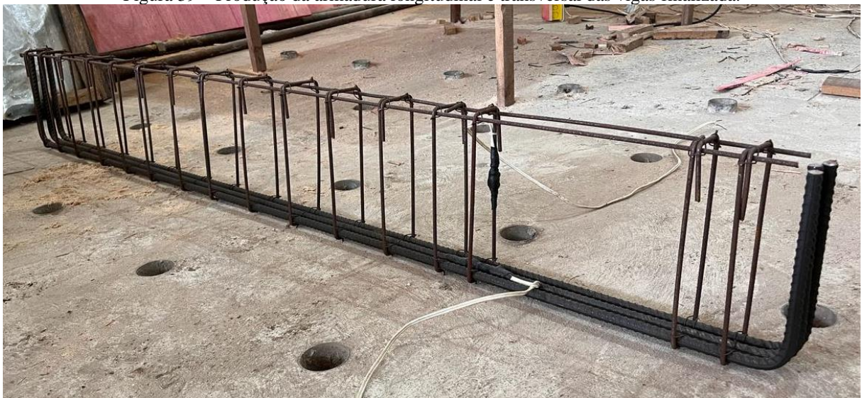
Figura 39 – Produção da armadura longitudinal e transversal das vigas finalizada.
